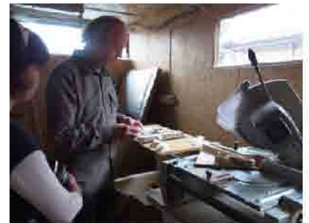
20:パーツの切断
