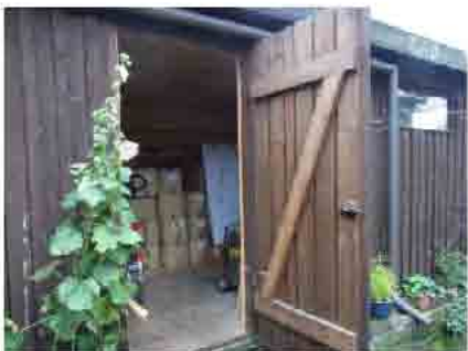
39: お庭に建てられた納屋。つまり倉庫です。
